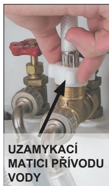
UTAŽENÁ POJISTNÁ MATICE T-ADAPTÉRU
